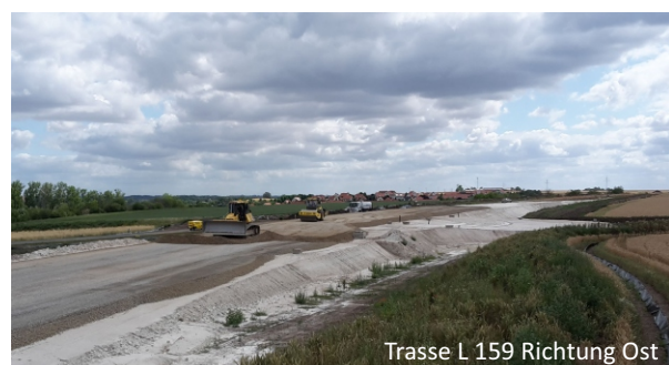
Trasse L 159 Einschnitt
